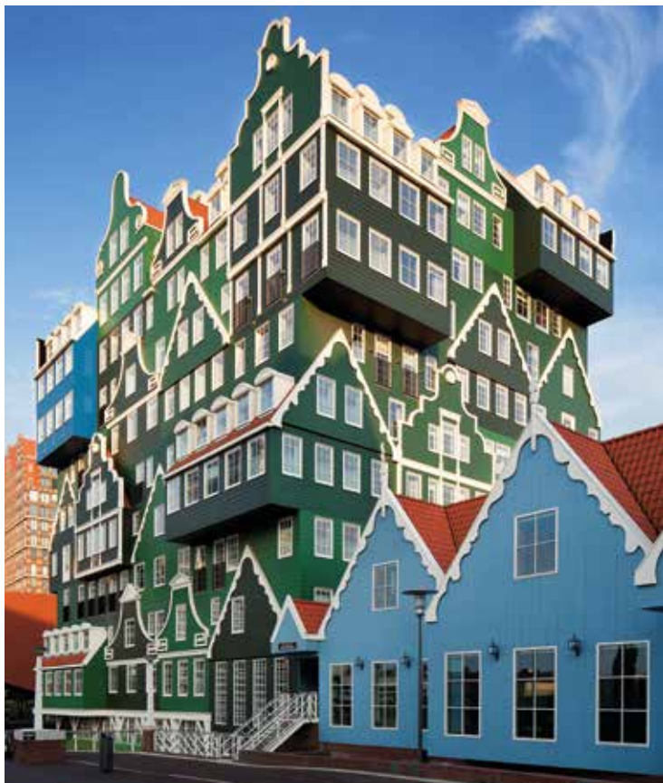
Het Intel-hotel in Zaandam, geopend in 2010. Een ode aan Zaanse houtbouw, maar niet in hout uitgevoerd. Architect: Wilfried van Winden (WAM Architecten/Molenaar & Van Winden Architecten). (Foto: Peter Barnes)
