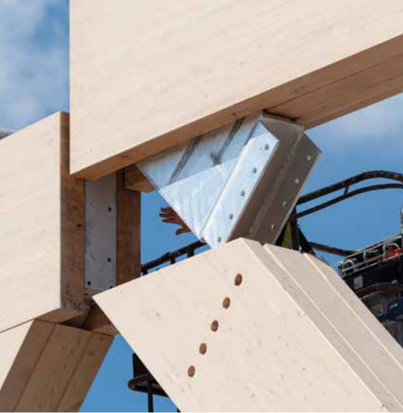
Het Koning Willem I college in Den Bosch bestaat uit constructie van houten pre-fab elementen, ontwerp: Nieuwe Architecten. (Foto: Stijn Poelstra)
