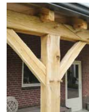
Een voorbeeld van traditionele houtbouw: standvinken, korbelen en pen-en-gatverbindingen. FOTO JAN PIET BLOEM
